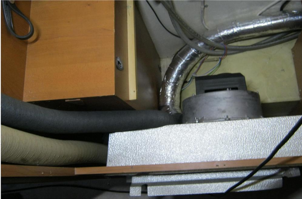
Und hier ein Blick hinter die Heizung – oben das isolierte Rohr geht zum Bad und zur Sitzecke. Links das dickere Rohr ist die Abgasleitung und daneben das graue Rohr dient zum absaugen der Warmluft aus dem Schrank.
