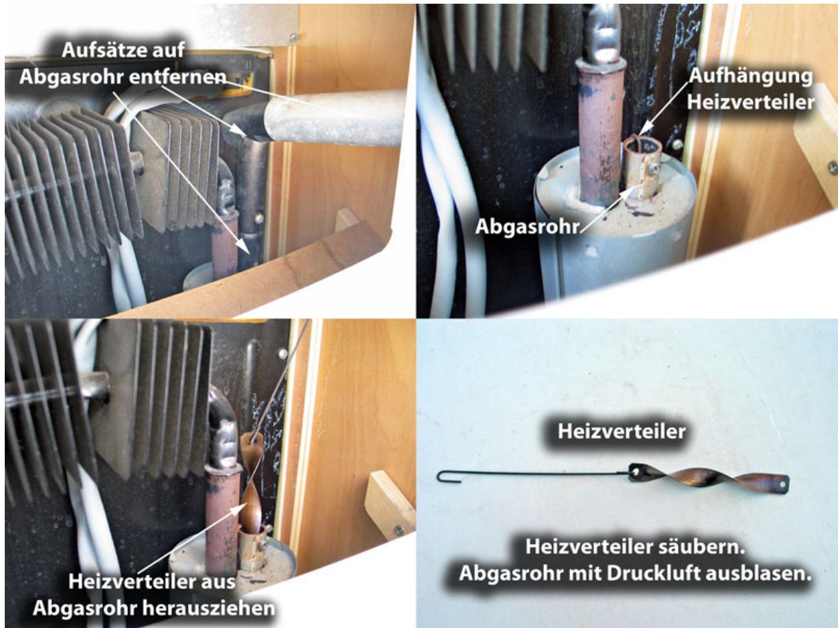
Bei Einführen des Heizverteilers in das Abgasrohr können sich noch Rückstände lösen und auf den Brenner fallen.
