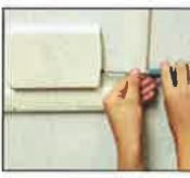
Abdeckung oben aufsetzen und neuen Filter in die vorhandene Fixierung einsetzen.
